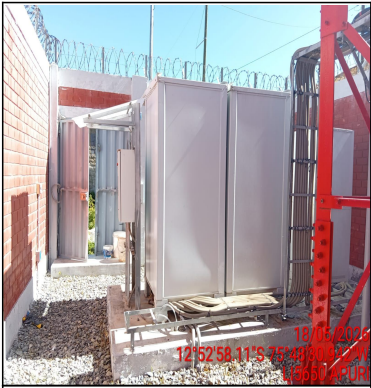
Foto Panorámica del Interior del Site
