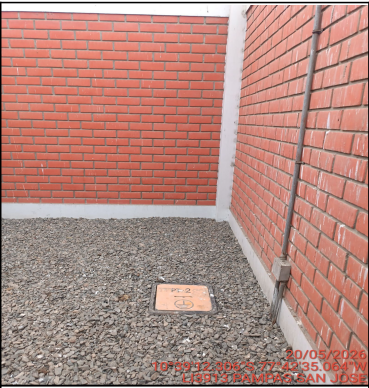
Foto Panorámica del Interior del Site
