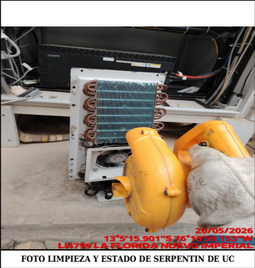
FOTO LIMPIEZA Y ESTADO DE SERPENTIN DE UC
