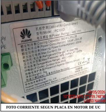
FOTO CORRIENTE SEGUN PLACA EN MOTOR DE UC
