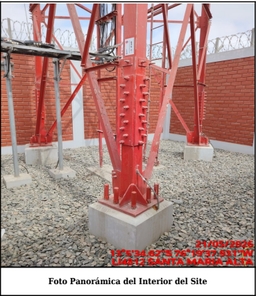
Foto Panorámica del Interior del Site
