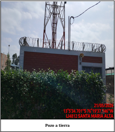
Pozo a tierra
