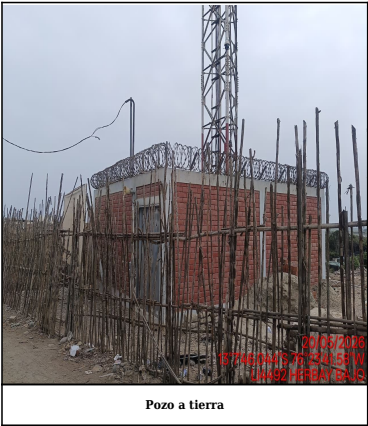
Pozo a tierra
