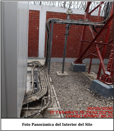
Foto Panorámica del Interior del Site
