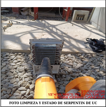
FOTO LIMPIEZA Y ESTADO DE SERPENTIN DE UC
