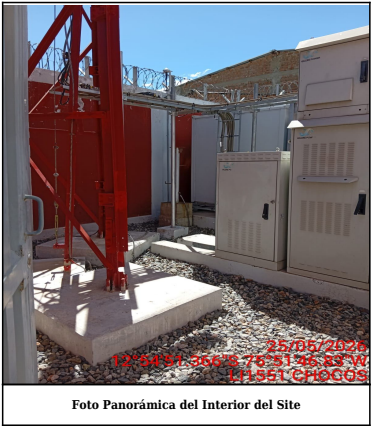
Foto Panorámica del Interior del Site
