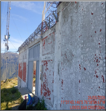
Pozo a tierra
