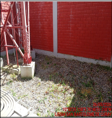
Foto Panorámica del Interior del Site
