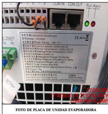
FOTO DE PLACA DE UNIDAD EVAPORADORA
