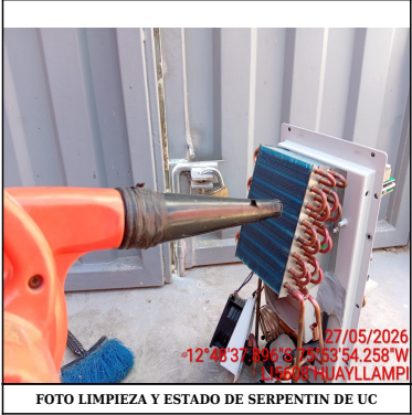
FOTO LIMPIEZA Y ESTADO DE SERPENTIN DE UC
