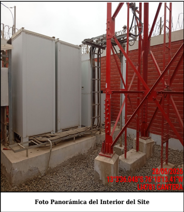
Foto Panorámica del Interior del Site
