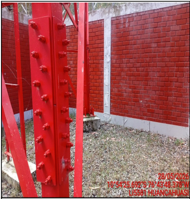
Foto Panorámica del Interior del Site
