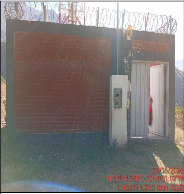
Pozo a tierra
