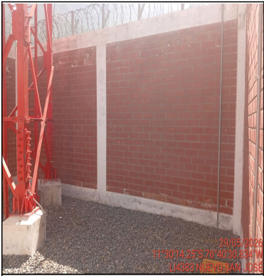
Foto Panorámica del Interior del Site
