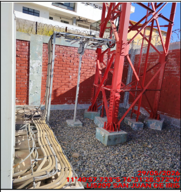
Foto Panorámica del Interior del Site
