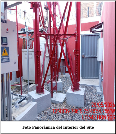
Foto Panorámica del Interior del Site
