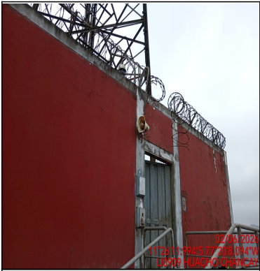
Foto Panorámica del Interior del Site
