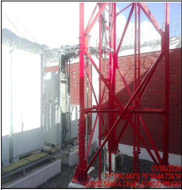
Foto Panorámica del Interior del Site
