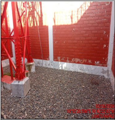
Foto Panorámica del Interior del Site
