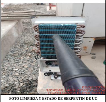
FOTO LIMPIEZA Y ESTADO DE SERPENTIN DE UC
