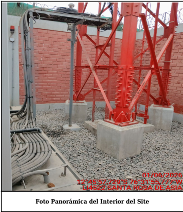
Foto Panorámica del Interior del Site
