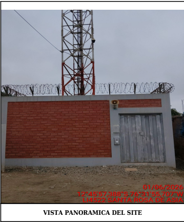
VISTA PANORAMICA DEL SITE
