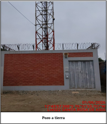
Pozo a tierra
