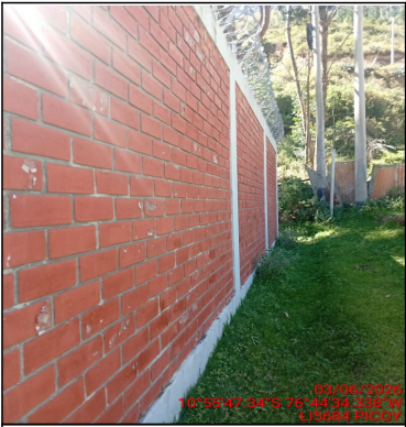
Pozo a tierra
