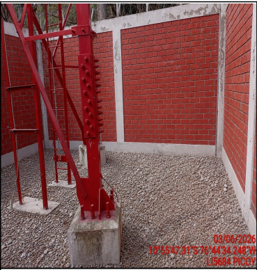
Foto Panorámica del Interior del Site
