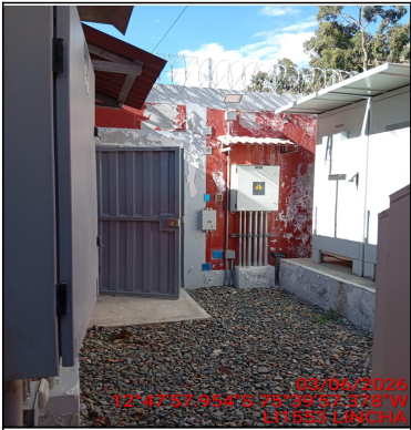
Foto Panorámica del Interior del Site
