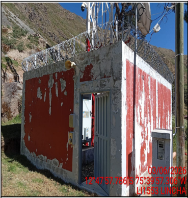
Pozo a tierra
