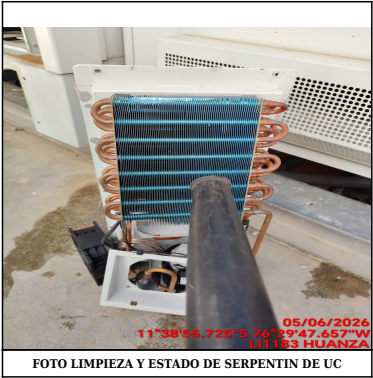
FOTO LIMPIEZA Y ESTADO DE SERPENTIN DE UC
