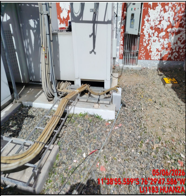
Foto Panorámica del Interior del Site
