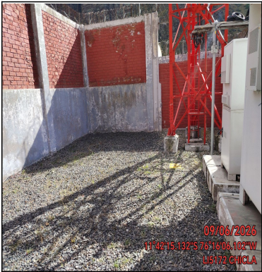
Foto Panorámica del Interior del Site
