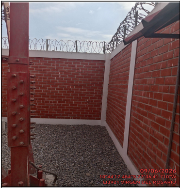
Foto Panorámica del Interior del Site
