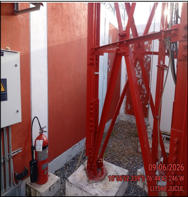
Foto Panorámica del Interior del Site
