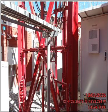
Foto Panorámica del Interior del Site
