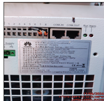
FOTO DE PLACA DE UNIDAD CONDENSADORA
