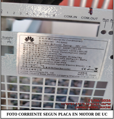
FOTO CORRIENTE SEGUN PLACA EN MOTOR DE UC
