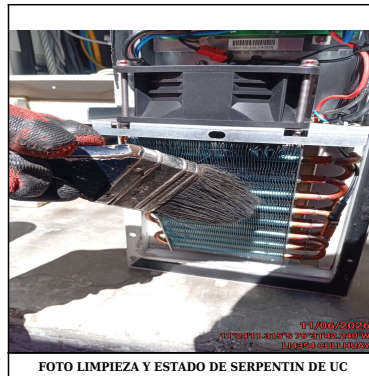
FOTO LIMPIEZA Y ESTADO DE SERPENTIN DE UC
