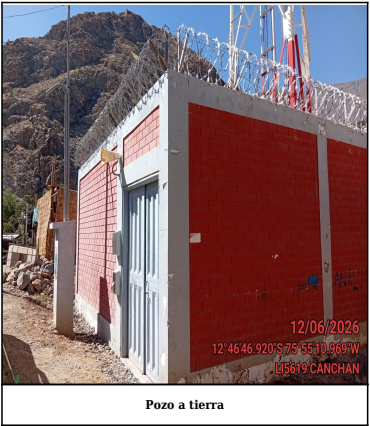
Pozo a tierra
