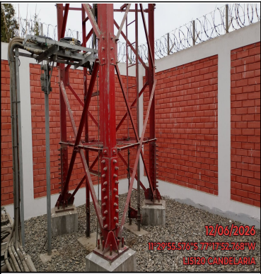
Foto Panorámica del Interior del Site
