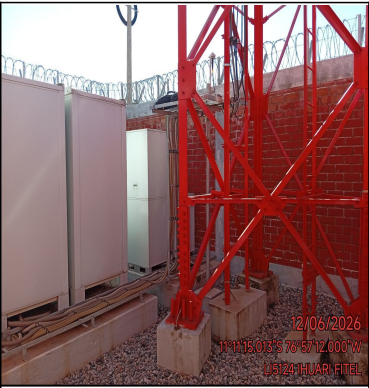
Foto Panorámica del Interior del Site
