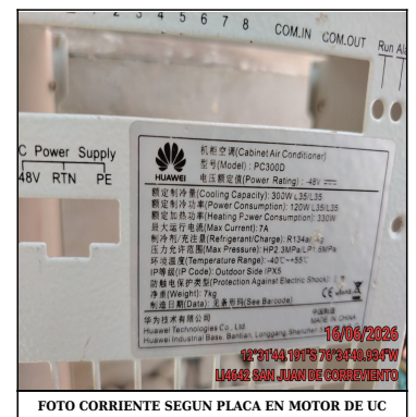
FOTO CORRIENTE SEGUN PLACA EN MOTOR DE UC
