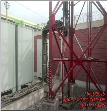
Foto Panorámica del Interior del Site
