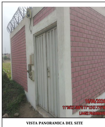
VISTA PANORAMICA DEL SITE
