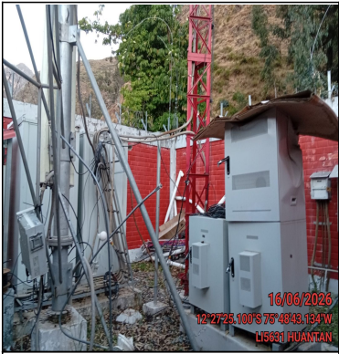
Foto Panorámica del Interior del Site
