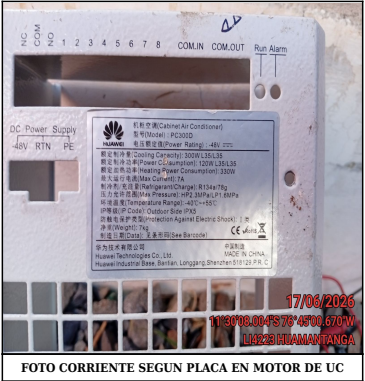
FOTO CORRIENTE SEGUN PLACA EN MOTOR DE UC
