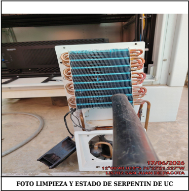
FOTO LIMPIEZA Y ESTADO DE SERPENTIN DE UC
