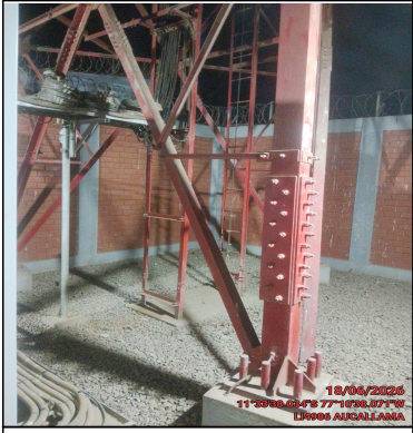
Foto Panorámica del Interior del Site
