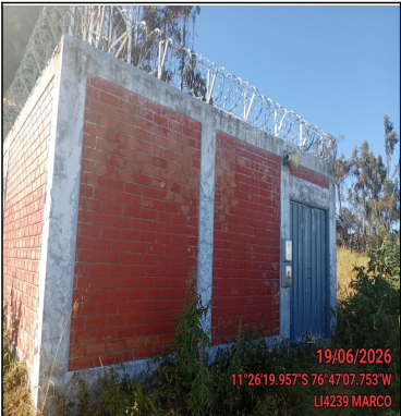
Pozo a tierra
