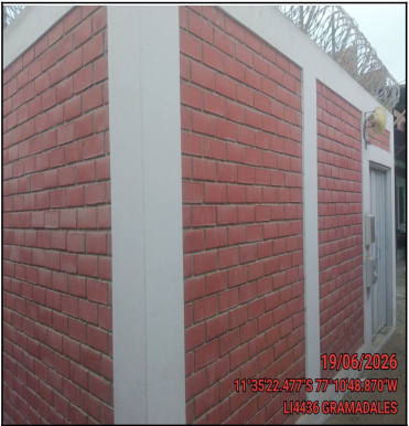
Pozo a tierra
