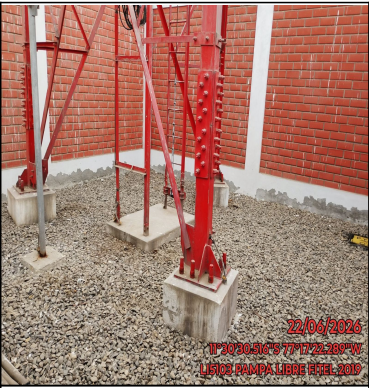
Foto Panorámica del Interior del Site
