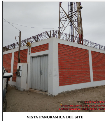
VISTA PANORAMICA DEL SITE
