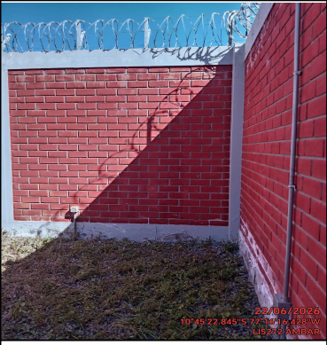
Foto Panorámica del Interior del Site
