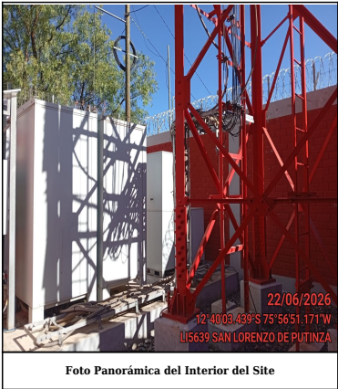
Foto Panorámica del Interior del Site
