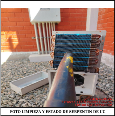
FOTO LIMPIEZA Y ESTADO DE SERPENTIN DE UC
