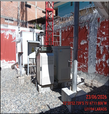
Foto Panorámica del Interior del Site
