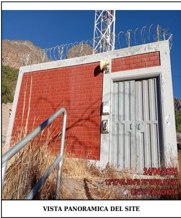
VISTA PANORAMICA DEL SITE
