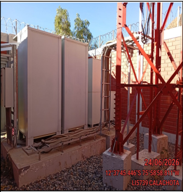
Foto Panorámica del Interior del Site
