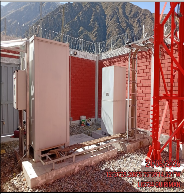
Foto Panorámica del Interior del Site
