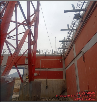
Foto Panorámica del Interior del Site
